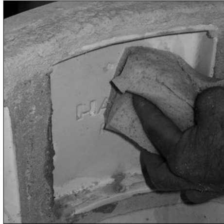
Kachelring innen mit einem Schwamm anfeuchten.
