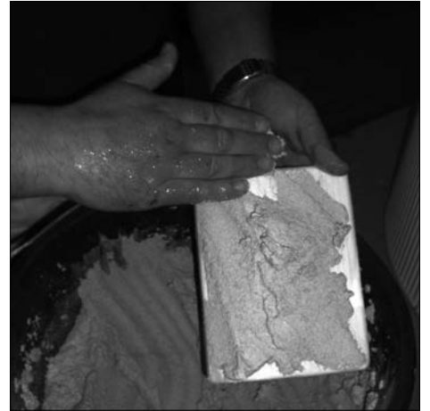
Mörtel auf den Schamottefutterstein auftragen.
